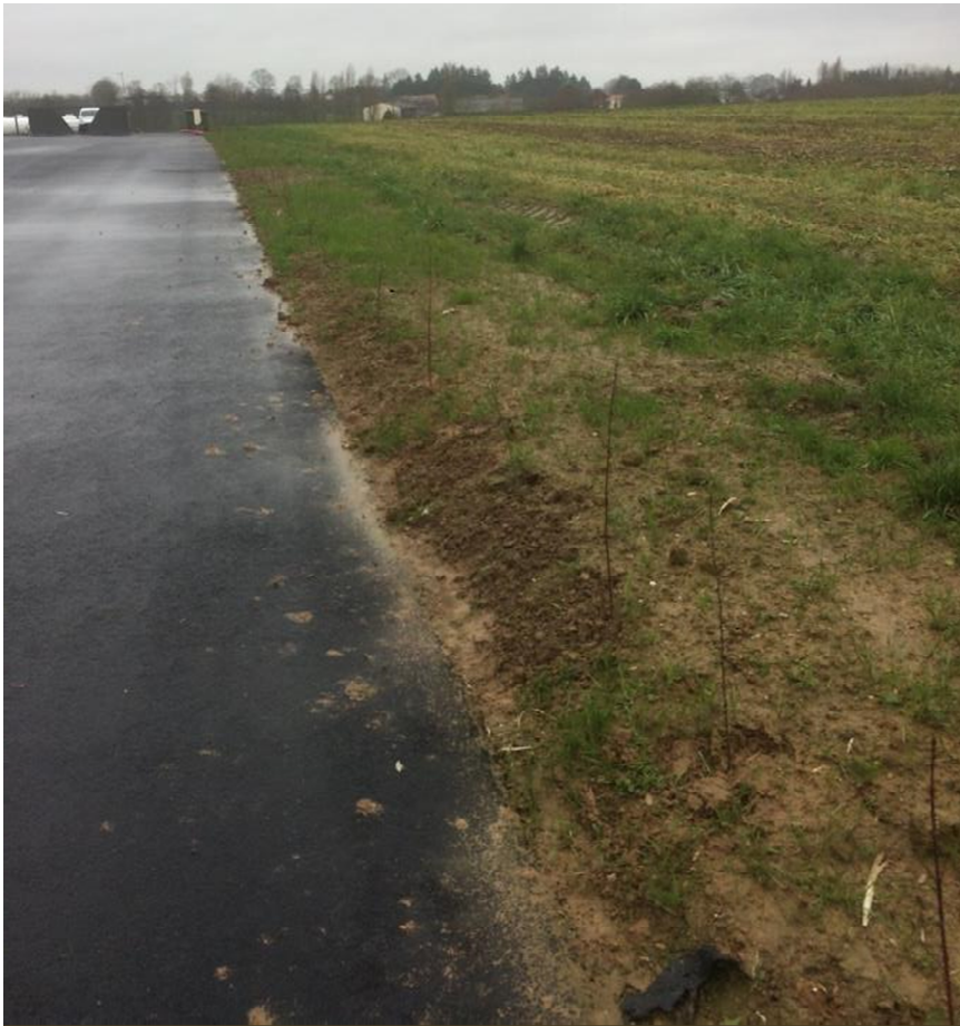
Vue 7 : Vue depuis l'angle Nord-Est du site sur les premières plantations effectuées
